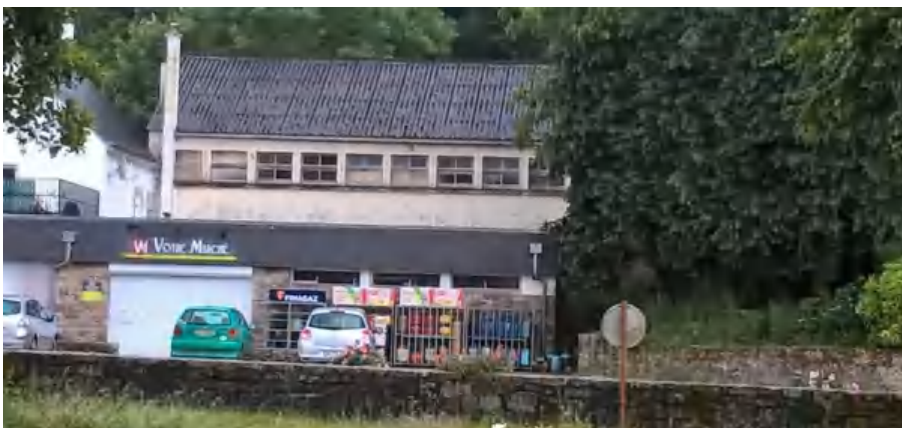
Requalification nécessaire de cette partie de la place de la mairie
