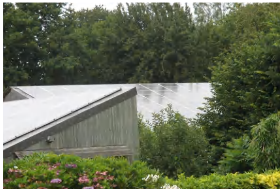
Toits d'un bâtiment d'activités et d'un hangar équipés en panneaux solaires photovoltaïques
